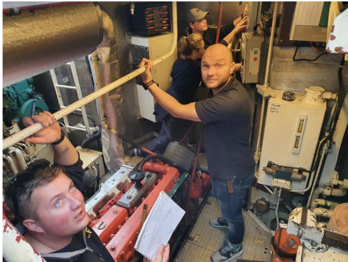
Arbete i maskinrummet på M/S Märsgarn.
